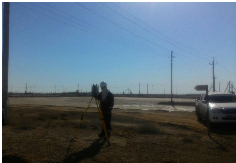
Рисунок 1.15 - Измерение высоты ЛЭП через тахеометр(TS-06)
